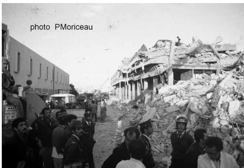
Obr.2 Zničené budovy po zemetrasení El Asnam, 1980
